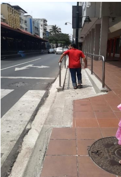
Figura 6. Rampa con pasamanos en la calle Boyacá. Fotografía: César Santana.
