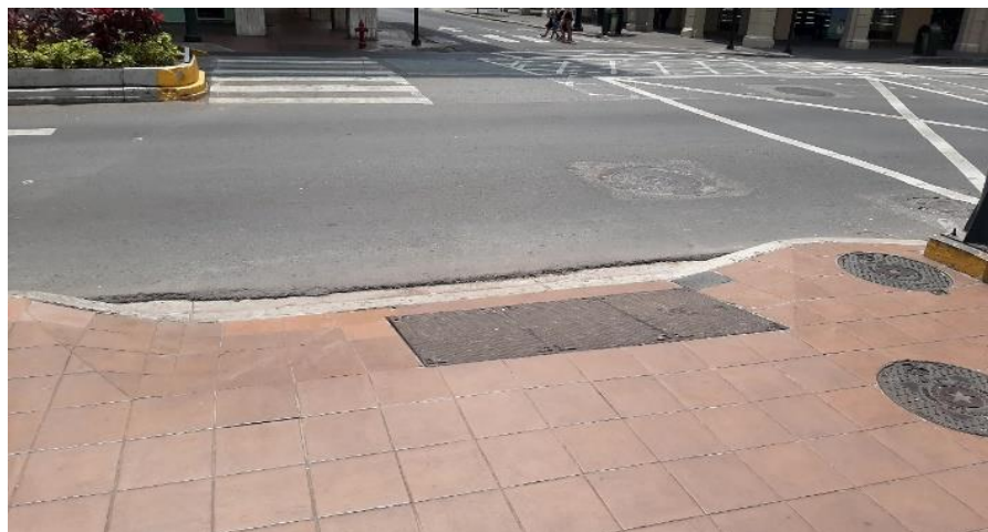
Figura 7. Tipo de material de construcción en la Calle Boyacá. Fotografía: César Santana.
